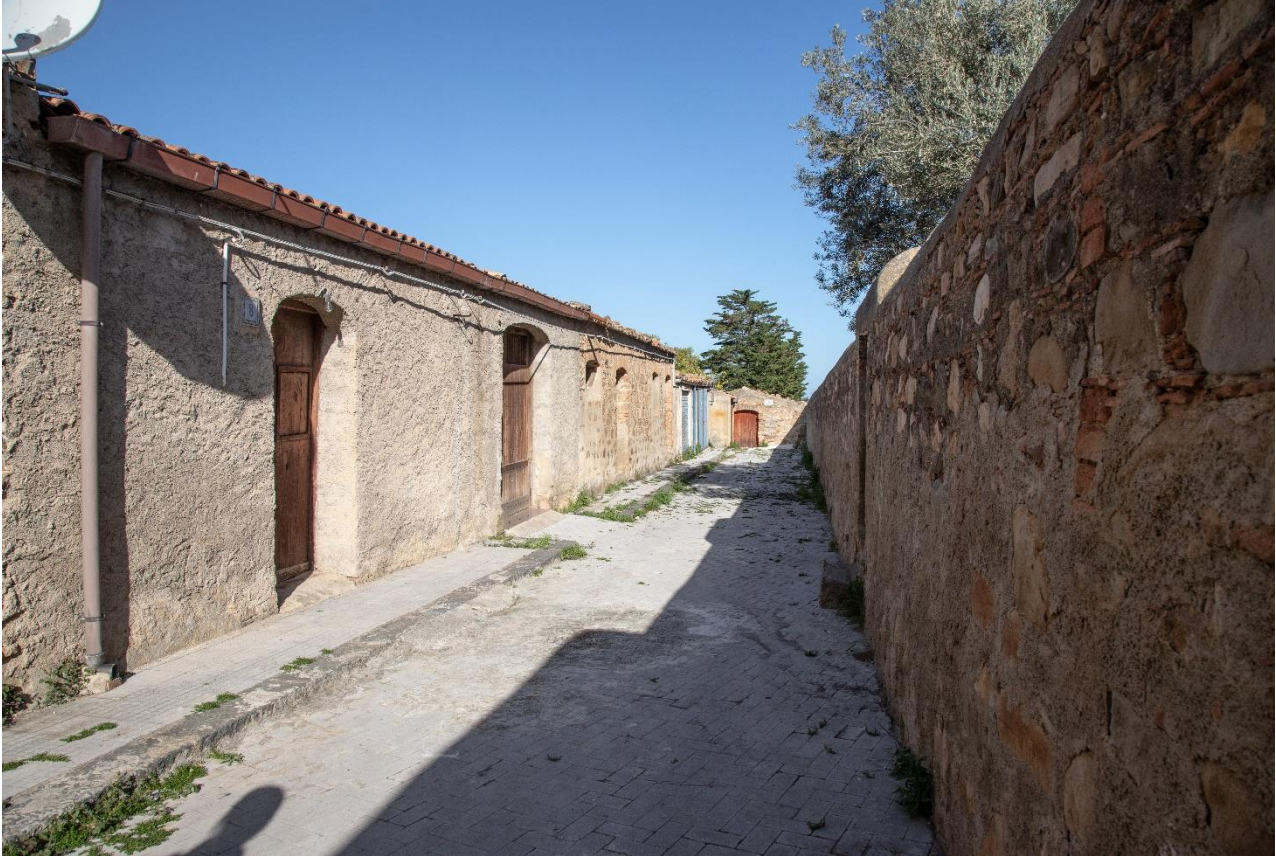
Figura 12. Pavimentazione Vicolo Gerbino
