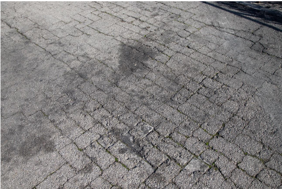
Figura 11. Pavimentazione Piazza Liborio Gerbino ricoperta di asfalto in cattivo stato a causa dell'usura
