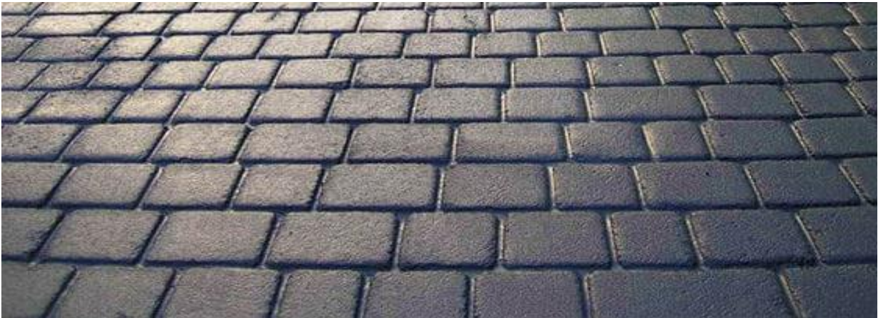
Figura 16. Asfalto stampato catalitico antismog
