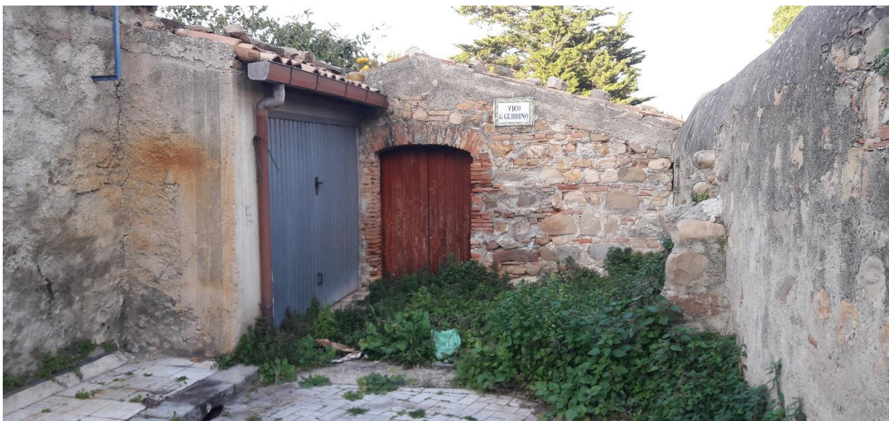
Vicolo Gerbino. Edificio a chiusura del vicolo che verrà demolito
