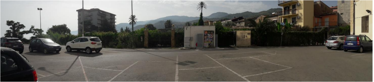
Vista di insieme della Pavimentazione Piazza Liborio Gerbino
