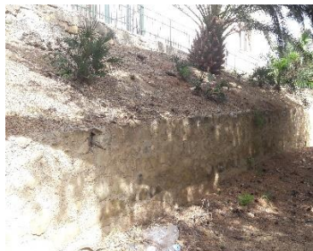
Terrazzamenti a monte
