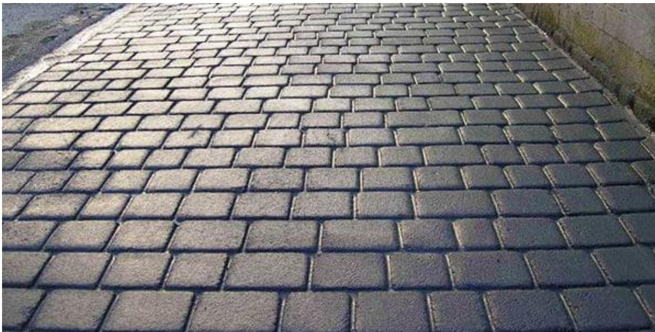
Esempio di asfalto stampato fotocatalitico
