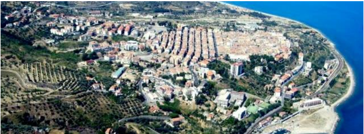
Figura 3. Area a valle di S. Stefano di Camastra
