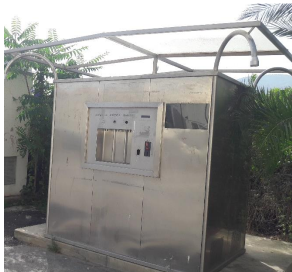
Casetta dell'acqua comunale
