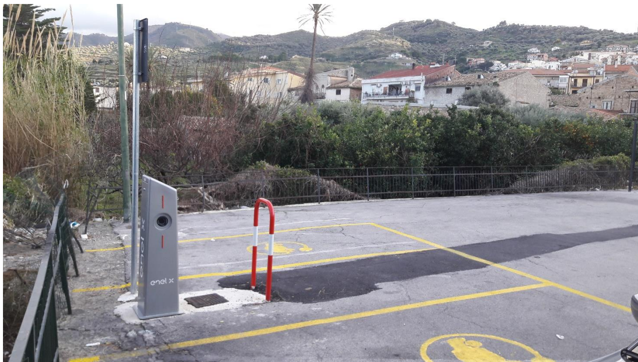
Colonnina di ricarica auto elettriche
