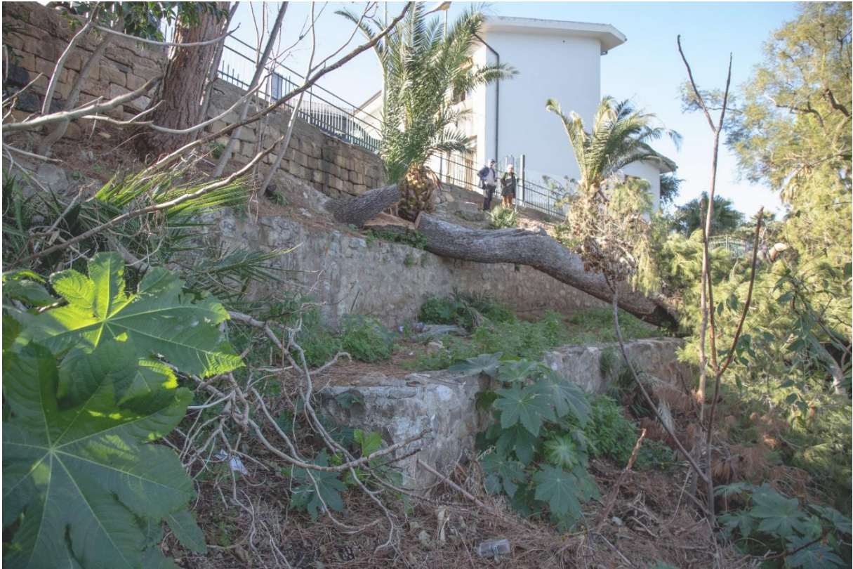
Figura 30. Terrazzamenti parcheggio piazza Liborio Gerbino
